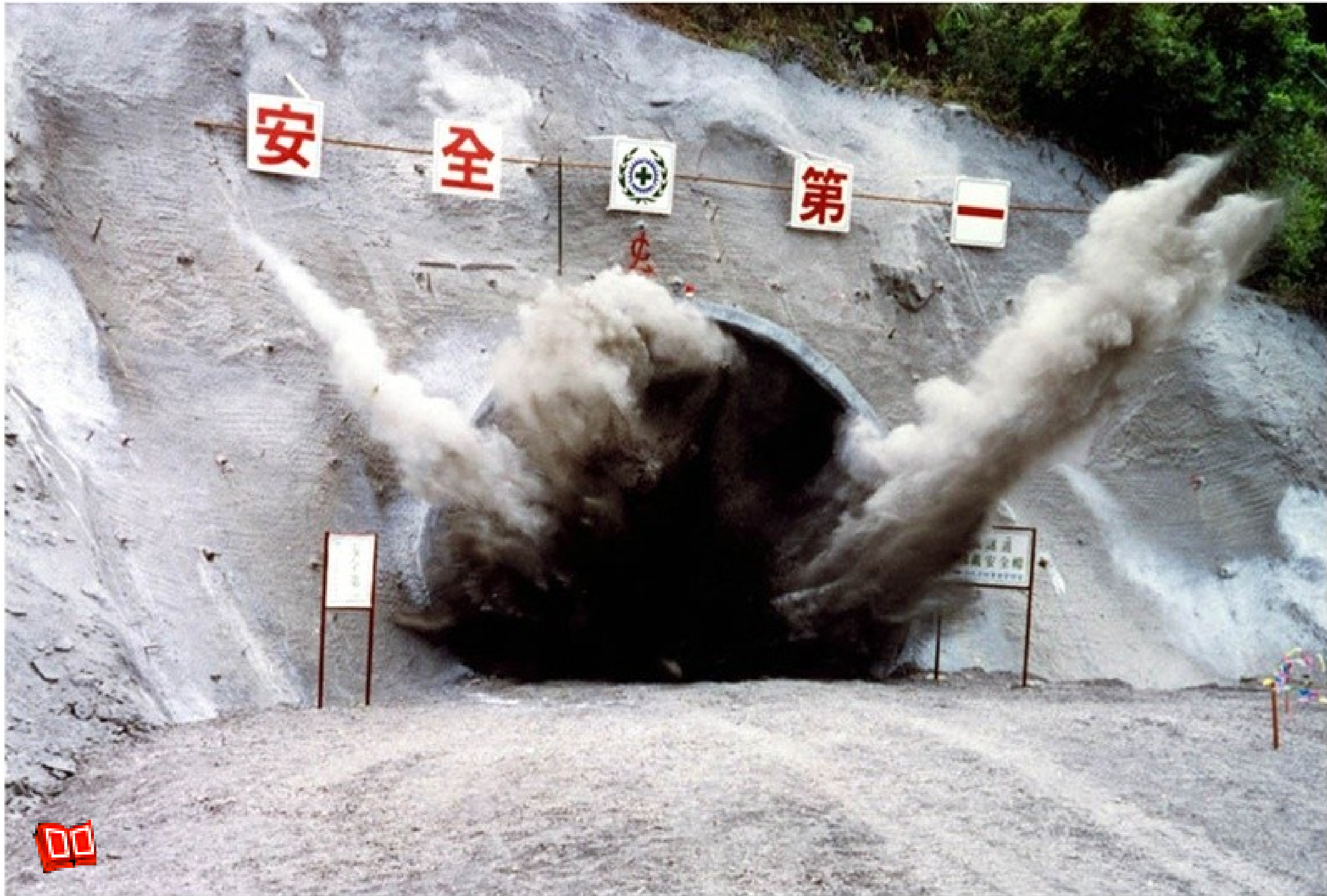
以炸藥從事隧道開挖，雪山隧道（資料來源：台灣區國道新建工程局）
