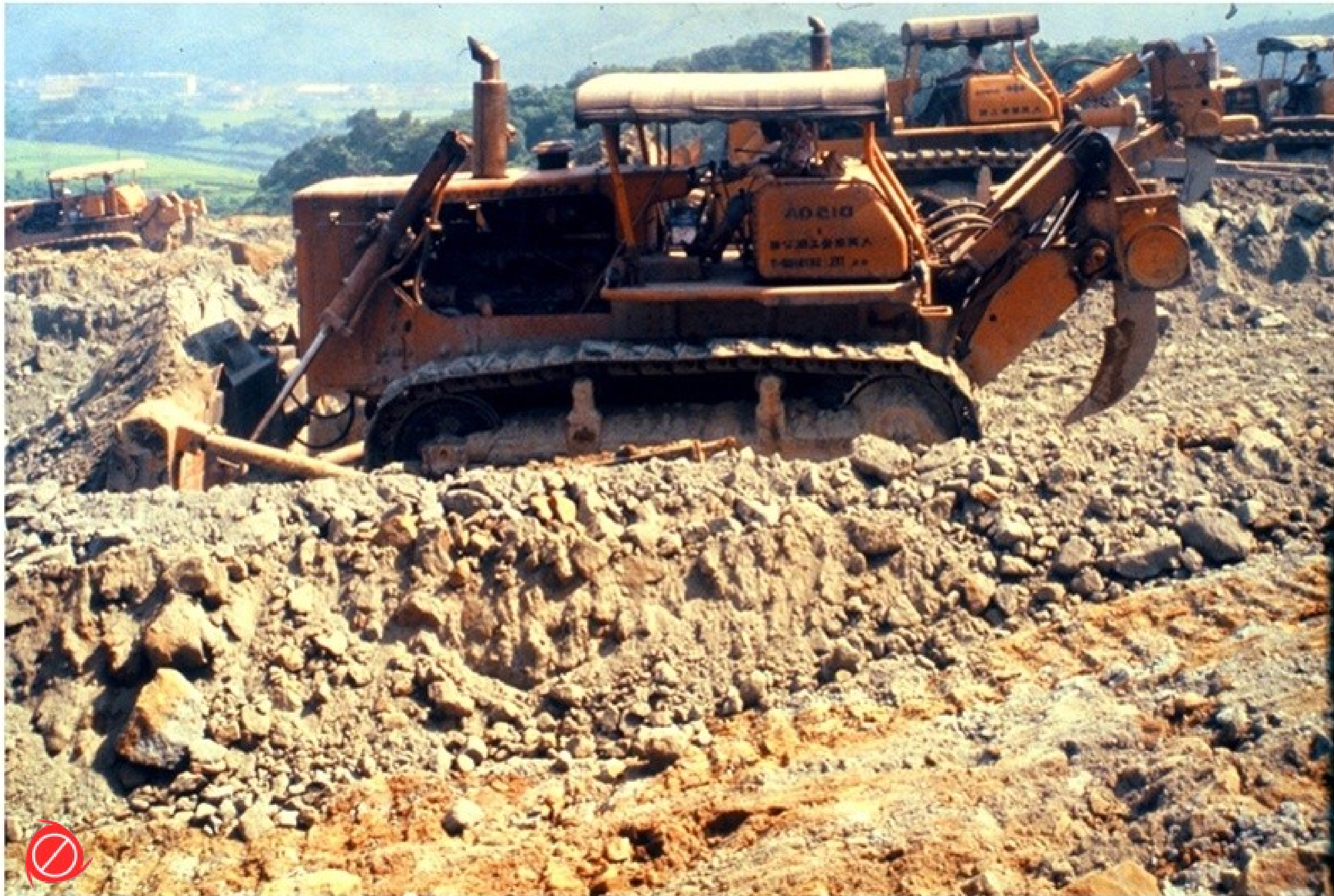
推土機進行整地作業
