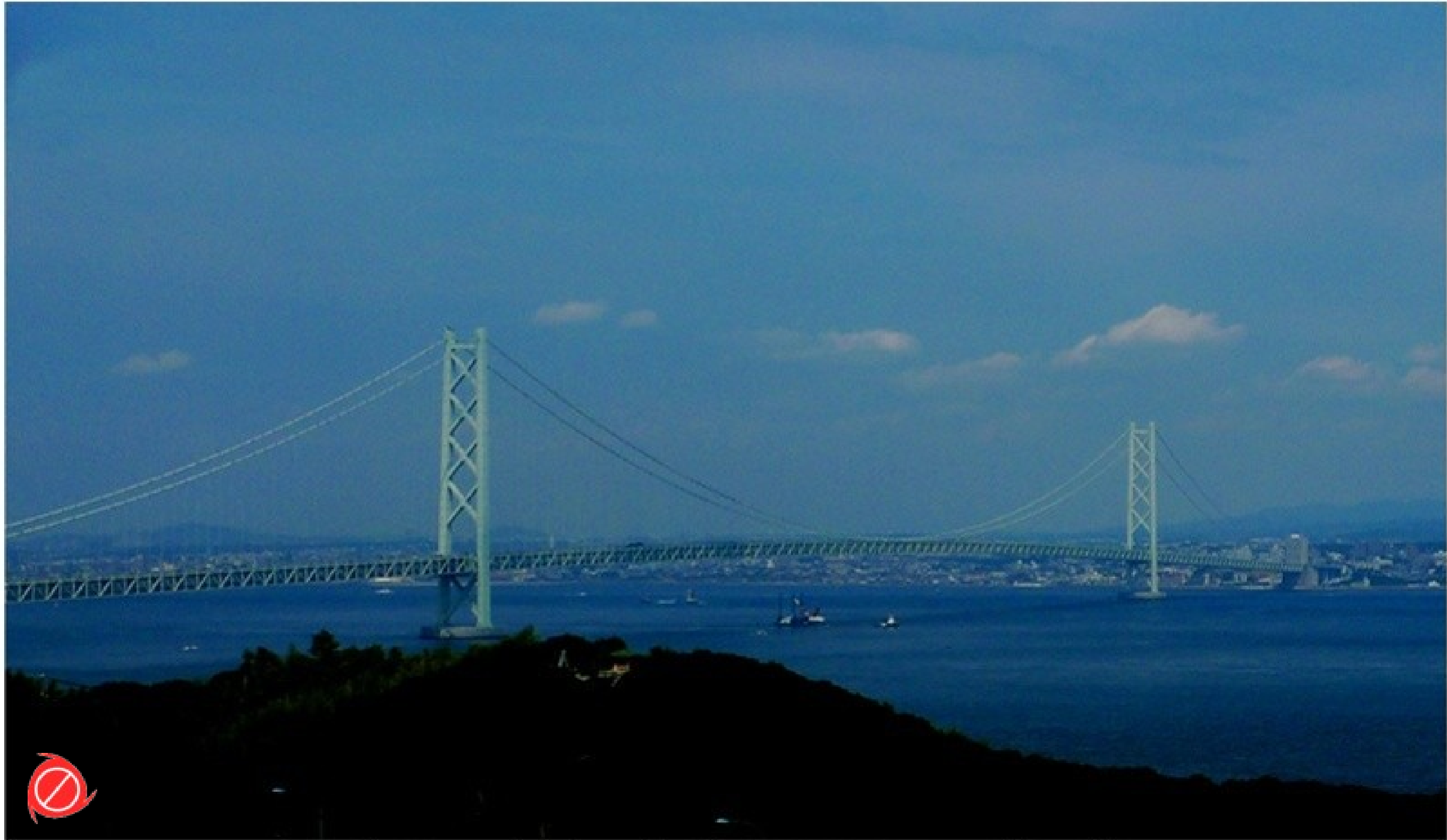
日本明石大橋，主跨1991公尺，世界第一（洪如江攝）
