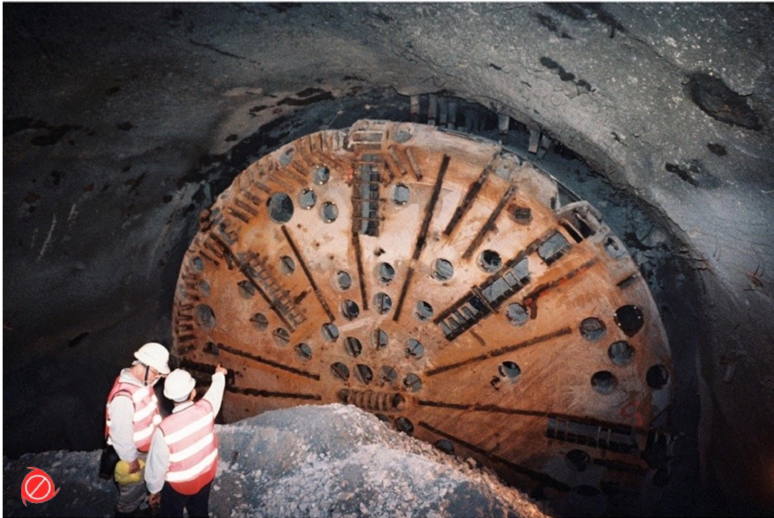
隧道鑽機 (TBM) 暫停維修中，雪山隧道
