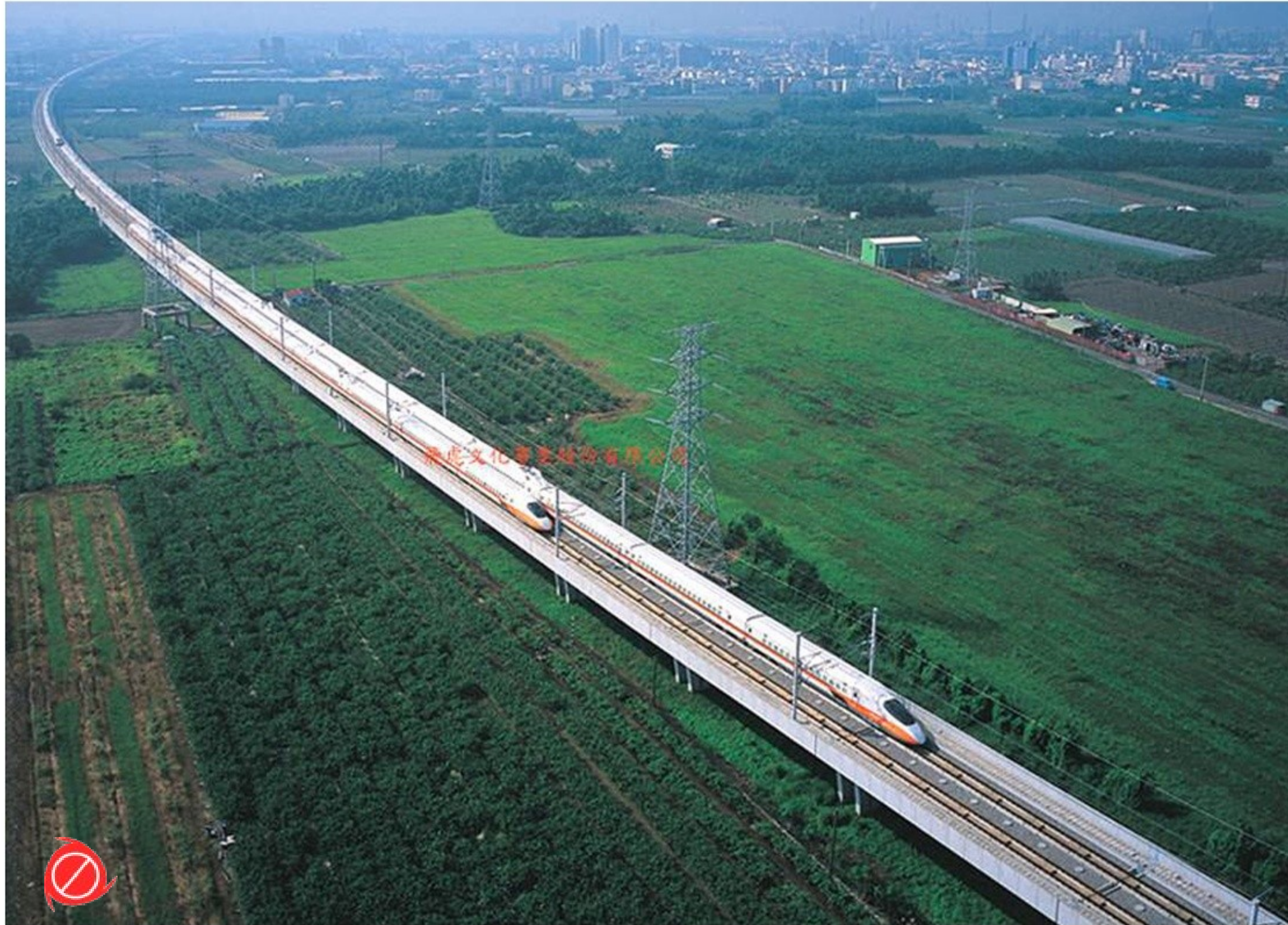
高速鐵路試車中
